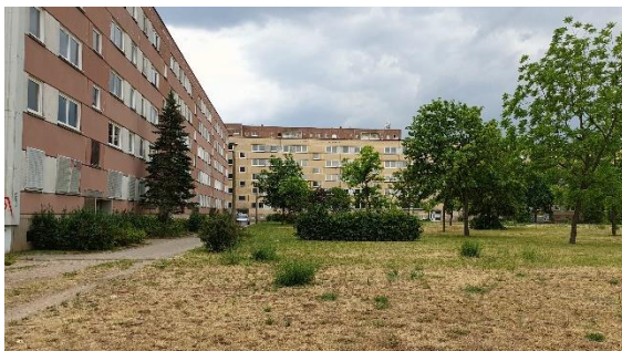
Abb.09: Plattenbauten im Wettbewerbsbereich, Quelle: ZGM Schwerin
